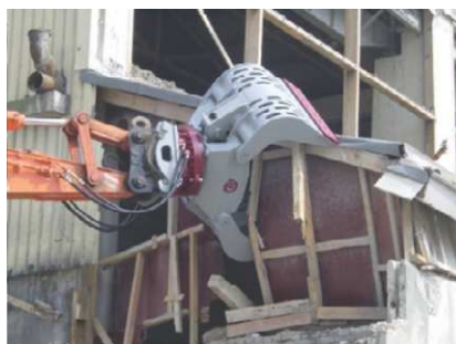
Фиг. 3. Грайфер за разрушаване и сортиране на материали – Demarec (Дания) [3].
